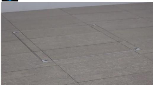
Dopo la completa asciugatura del cemento posizionate la pavimentazione esterna di finitura, sia nella vasca che all'esterno del telaio.
