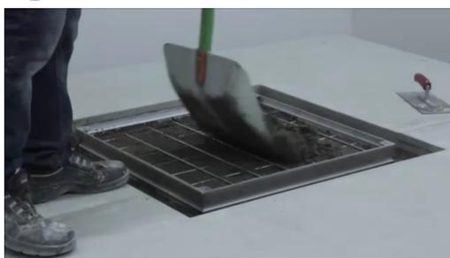
Posizionate la griglia di armatura e riempietela totalmente o parzialmente a filo della pavimentazione di finitura. Cementate anche l'esterno del chiusino totalmente o a filo della pavimentazione. Fate attenzione che la griglia deve essere coperta totalmente e proteggete sia viti che profili dal cemento.
