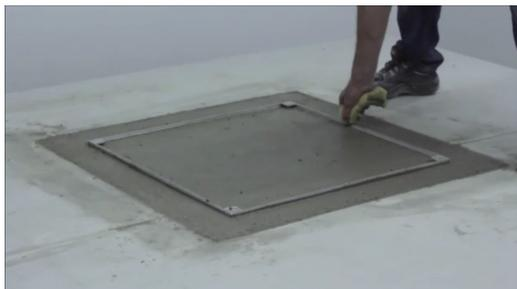
Una volta che il cemento ha raggiunto l'80% della durezza pulite i profili a vista del chiusino. Alla fine lasciate asciugare completamente il cemento, non appena il telaio esterno ha fatto presa con il cemento non si potrà più spostare.
