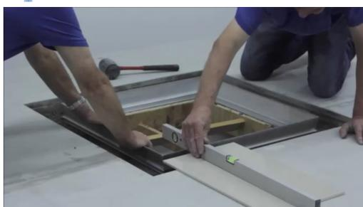
Posizionate il telaio esterno nel foro sul pavimento e verificate che sia a filo della pavimentazione esterna. Dovrebbe esserci minimo uno spazio di 130 mm da poter cementare.
