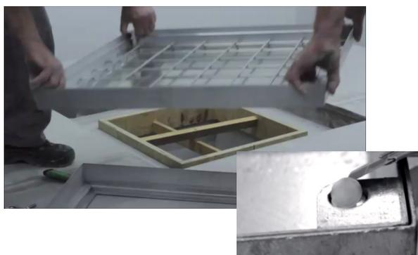
Rimuovete i tappini di chiusura, aprite le viti tramite le chiavi di sollevamento ed estraete la vasca dal telaio esterno.
