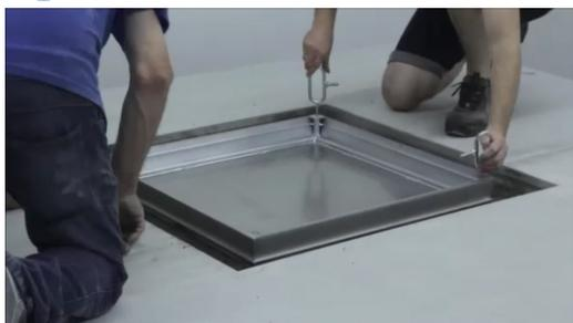
Riposizionate la vasca, chiudetela con le viti e rimettete i tappini. Controllate ancora una volta il corretto posizionamento del chiusino.
