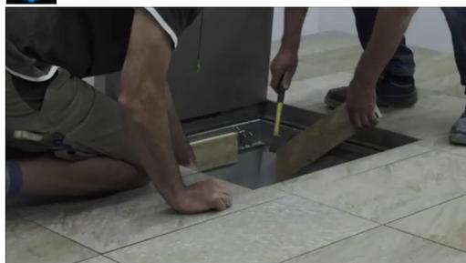
Rimuovete i tappini e aprite il chiusino d'ispezione. Rimuovete le assi utilizzate per la gettata.
