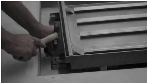
Fissate il chiusino agli ancoraggi laterali usando i perni forniti. Posizionato sotto una piattina, praticate i fori, inserite i bulloni e fissate le viti.
