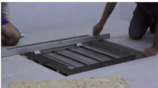
Posizionate il telaio esterno nel foro sul pavimento e verificate che sia a filo della pavimentazione esterna. Dovrebbe esserci minimo uno spazio di 130 mm da poter cementare. **Attenzione: i pistoni non devono essere montati**
