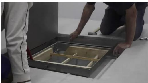
Aperte la vasca con le chiavi fornite e applicate una sufficiente gettata intorno al telaio.
