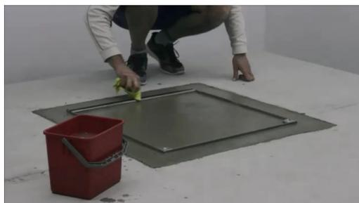
Una volta che il cemento ha raggiunto l'80% della durezza pulite i profili a vista del chiusino. Alla fine lasciate asciugare completamente il cemento, non appena il telaio esterno ha fatto presa con il cemento non si potrà più spostare.
