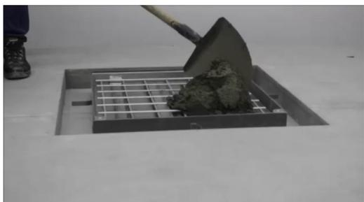
Posizionate la griglia di armatura e riempitela totalmente o parzialmente a filo della pavimentazione di finitura. Cementate anche l'esterno del chiusino totalmente o a filo della pavimentazione. Fate attenzione che la griglia deve essere coperta totalmente e proteggete sia viti che profili dal cemento.
